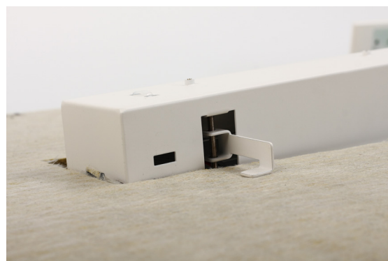
Bildexempel på förberedelse för infällt montage
